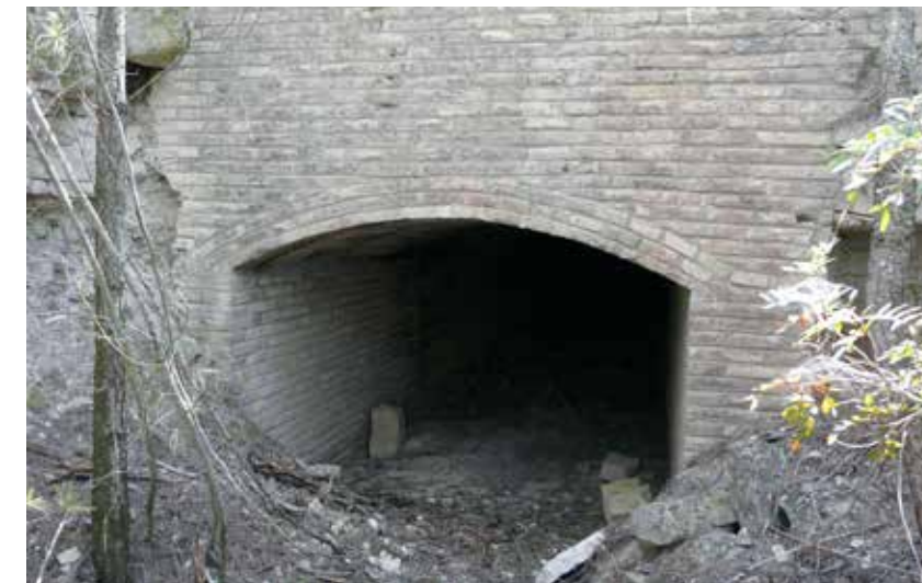
Accés obrat de maons d'una de les boques de l'abric de Punta Fraile.
