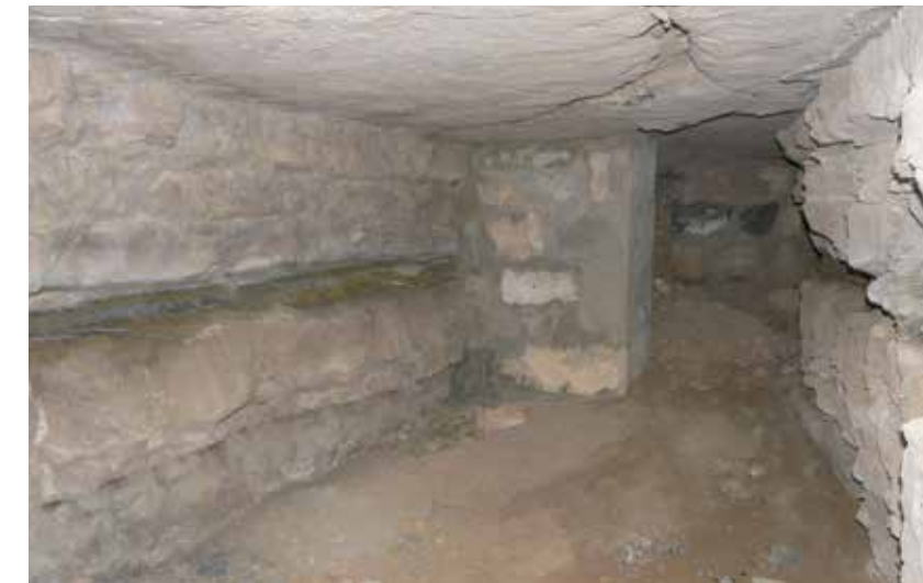
Interior de l'abric en galeria de mina de la posició Bernis.
